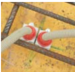
Příklad použití vývodky a koncovky.
