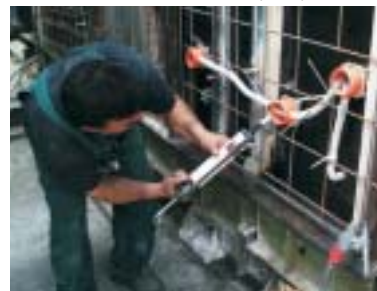
Utěsnění prostupů (tmel).
