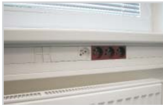
Příklad montáže parapetního kanálu PK 120X55 D.
