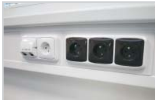
Příklad montáže parapetního kanálu PK 140X70 D.
