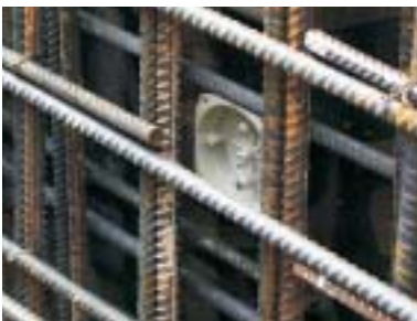
Víčko KBV připevněné na bednění.
