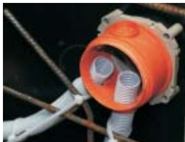
Namontované ohebné trubky do tělesa KBT.
