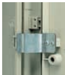
Kovové úchyty na dveřích bránící jejich vypáčení
