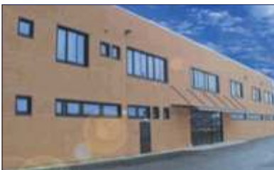
HEADQUARTERS - FVG ENERGY Carlino (UD) - ITALY
